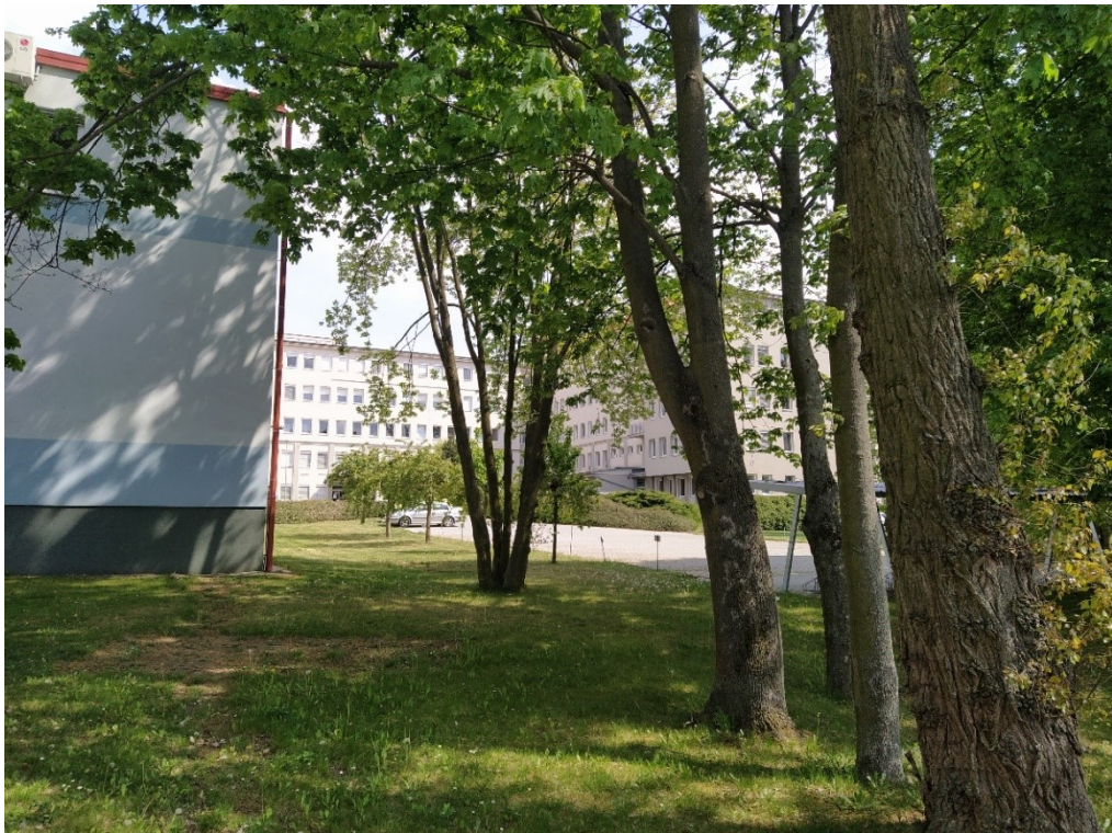
Obr. 20 Boční strana části budovy nemocnice a pohled do dvorního traktu areálu (vlastní fotografie)
