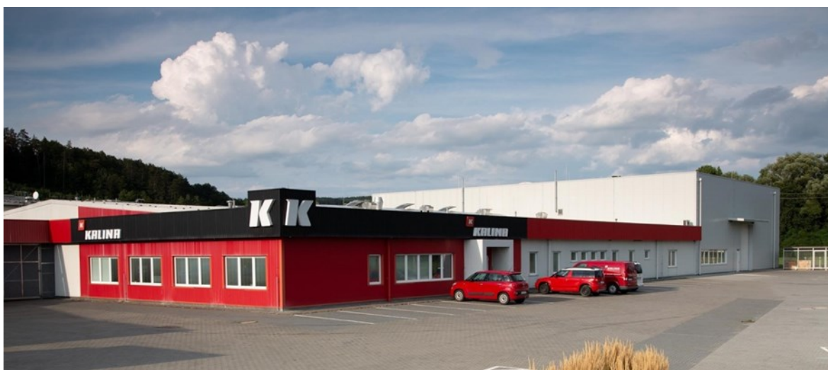
Obrázek 14 Sídlo společnosti KALINA industries, s.r.o. (interní materiály)
