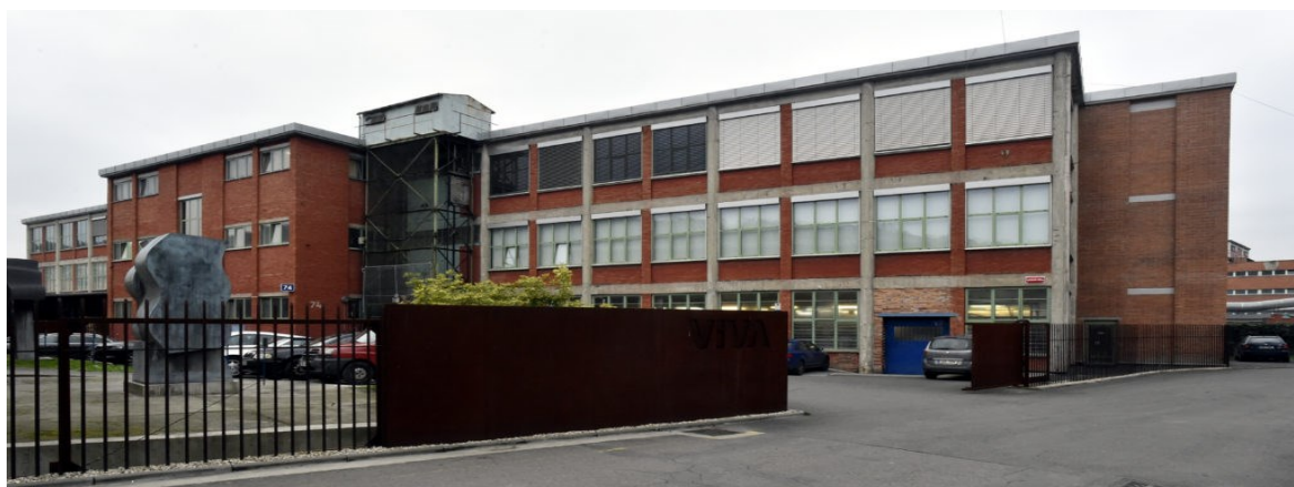
Obr. 11 Budova číslo 74 v továrním areálu (interní materiály společnosti)
