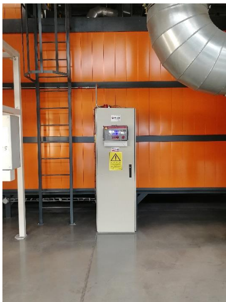
Obr. 17: Ústředna samočinného hasicího zařízení od RSBP
