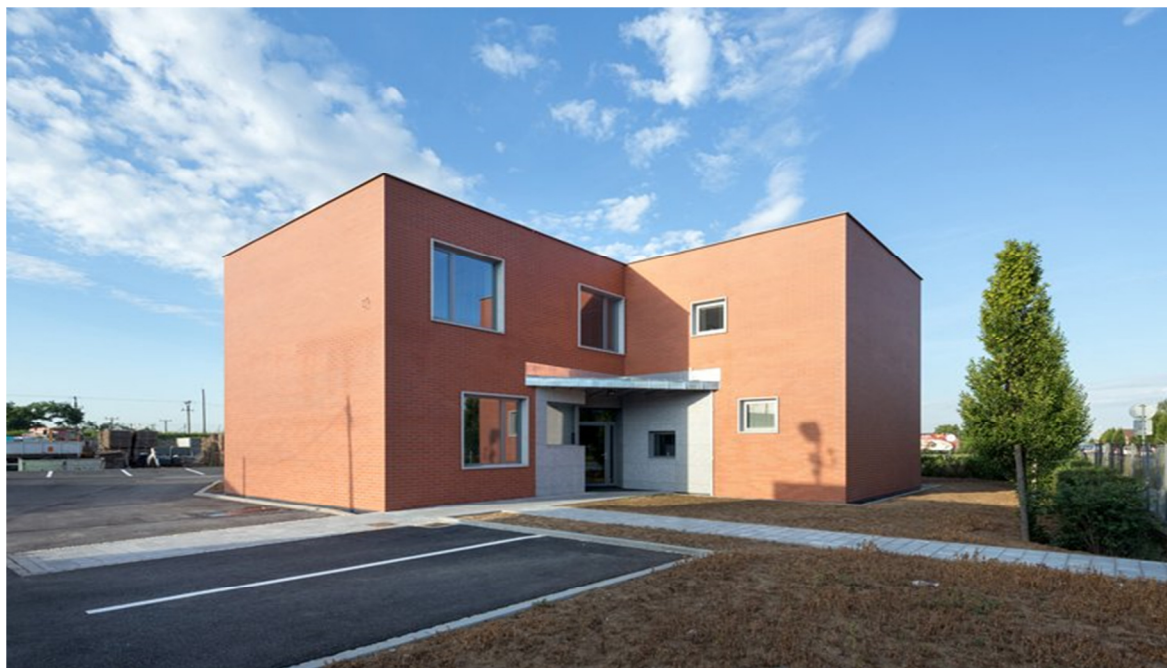
Obr. 15- Ilustrační foto vhodného místa pro výstavbu administrativní budovy [41]
