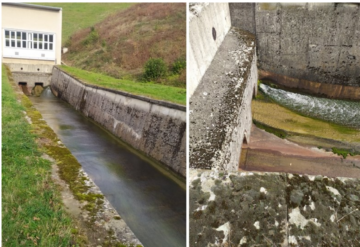
Obr. 13. – Odpadní koryto spodních výpustí, potrubí asanačního průtoku [zdroj: vlastní]
