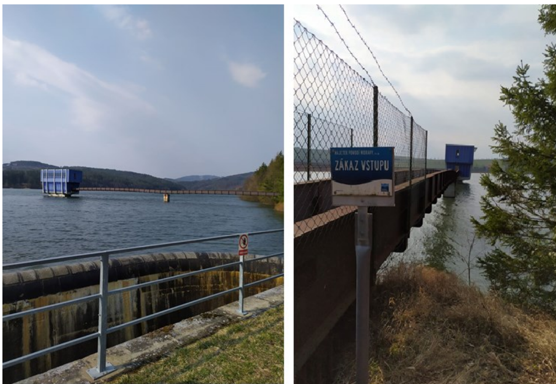
Obr. 11. – Strojovna vodárenských odběrů [zdroj: vlastní]
