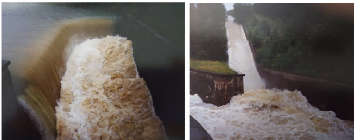
Obr. 17. – Povodně na vodním díle v roce 1997 [47]
