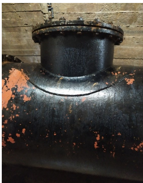
Obr. 18. – Spodní výpust [zdroj: vlastní]
