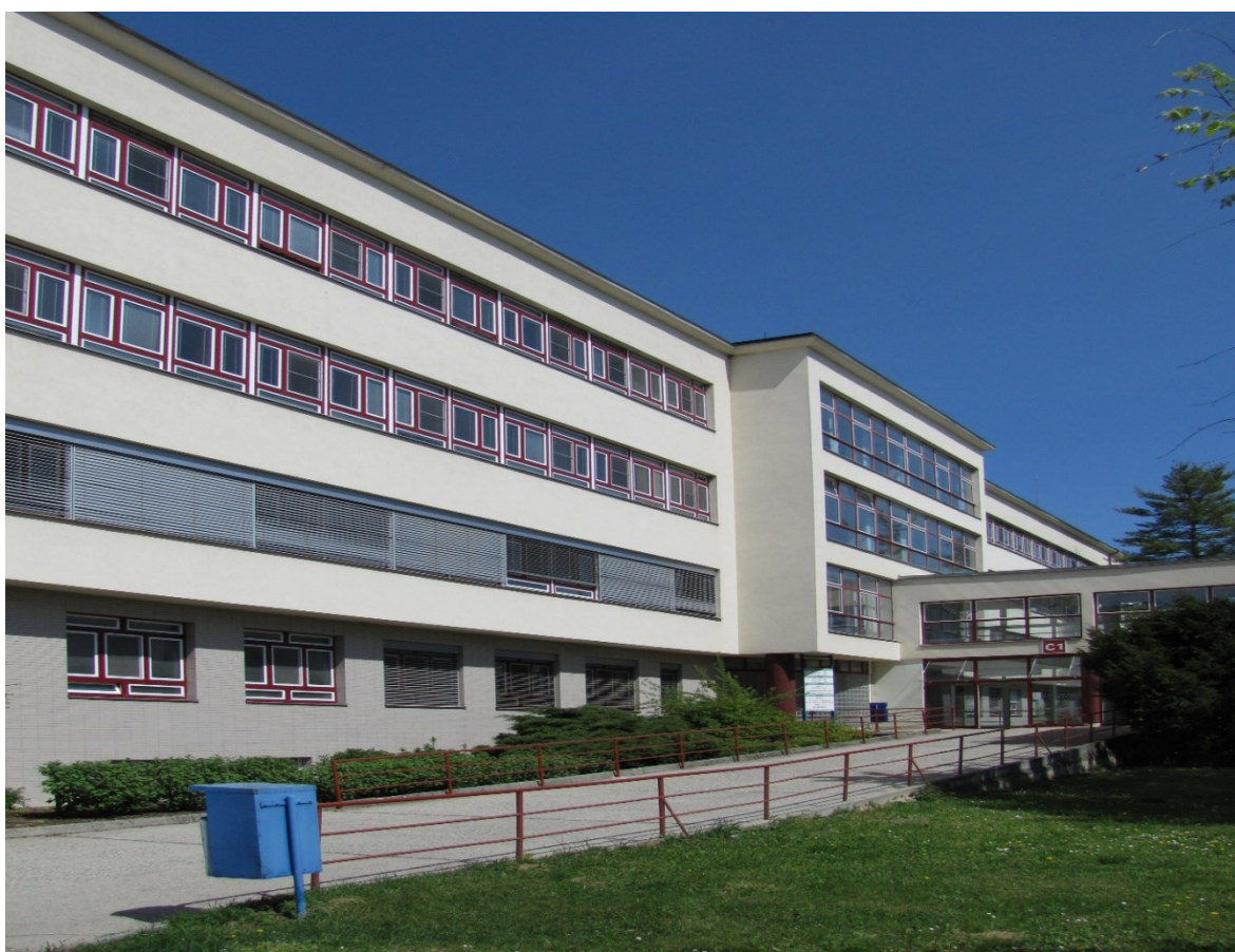
Obr. 3 Nemocnice Kyjov operační sály, ambulance a lůžková část [Zdroj:41]
