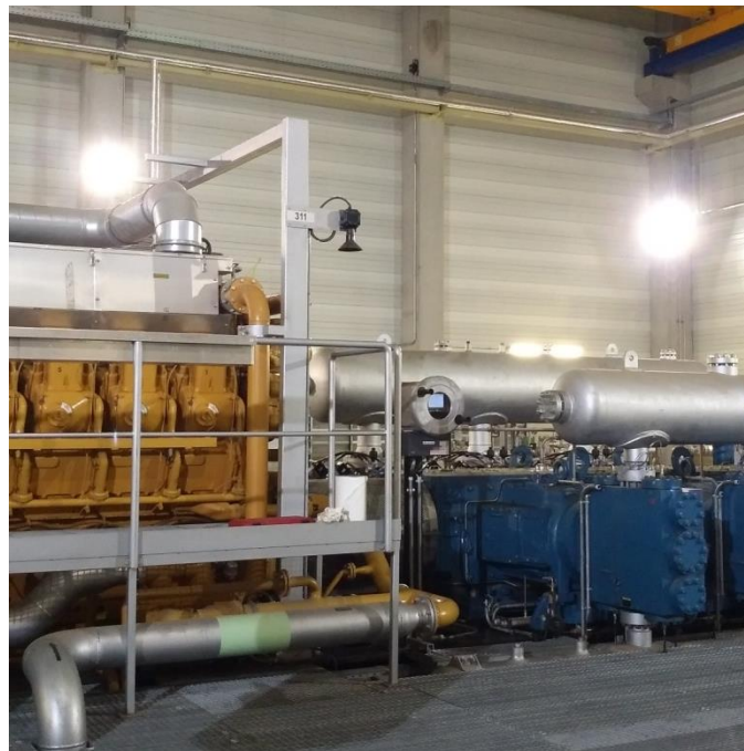
Obrázek 10 Detailnější záběr na plynový detekční systém. [zdroj vlastní]
