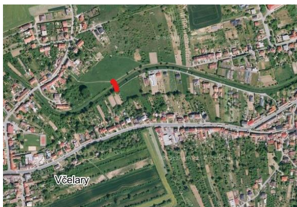
Obrázek 28: rekonstruovaná lávka [zdroj: 26]
