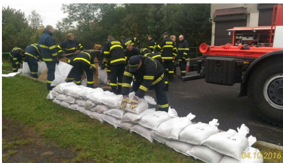
Obrázek 7: kladení pytlů s pískem [zdroj: 13]
