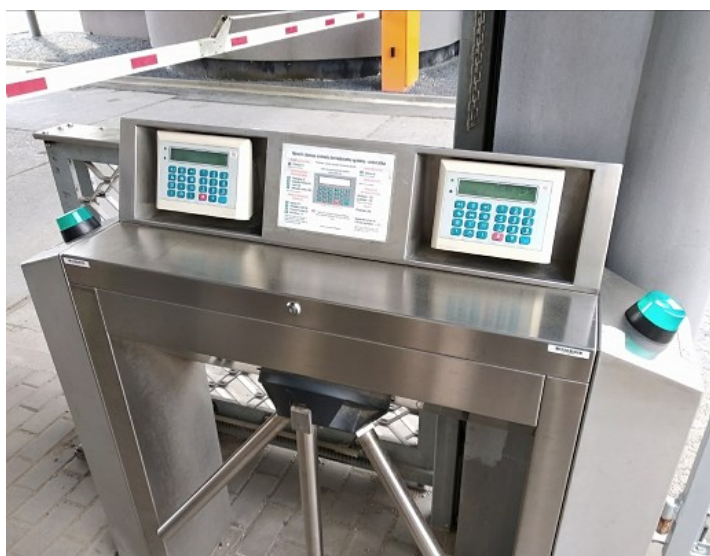
Obrázek 7 Turniket s docházkovým systémem [vlastní]
