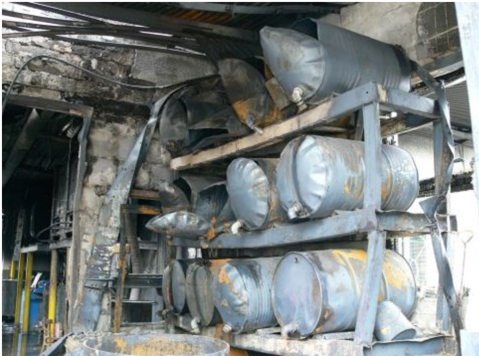
Obrázek 9 – Následky po požáru [17]
