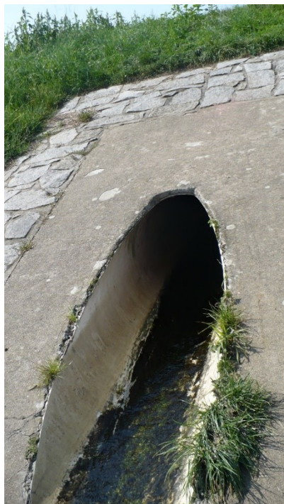
Obrázek 24 - nové potrubí ČOV [Zdroj: vlastní]
