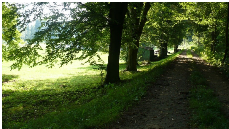
Obrázek 28 – Panenská, navýšení hráze [Zdroj: vlastní]
