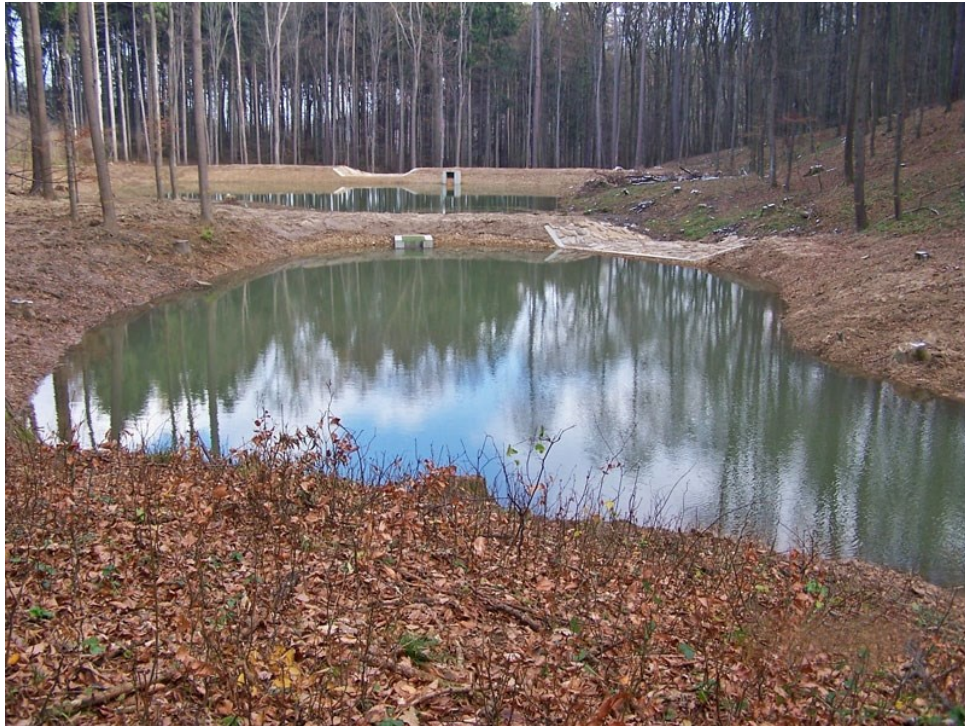
Obrázek 32 - Retenční nádrže [Zdroj: 24]
