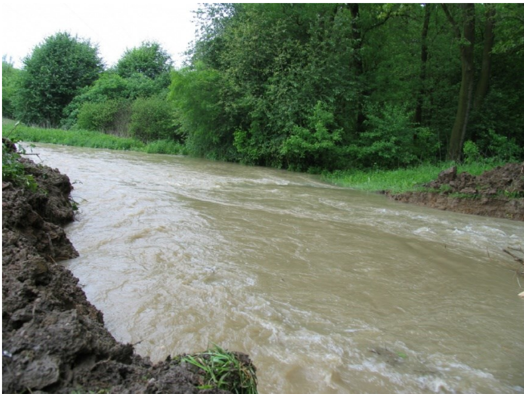
Obrázek 20 - Odstřelená hráz [Zdroj: 40]
