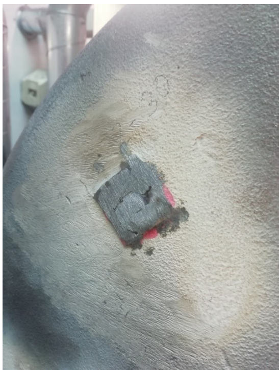
Obrázek 31: Připravený povrch pro aplikování tmelu
