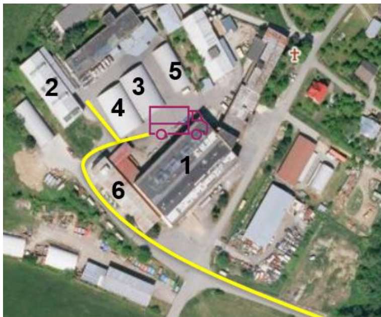
Obrázek 34 – Ukázka areálu a zdejších skladů společnosti (vlastní zpracování)
