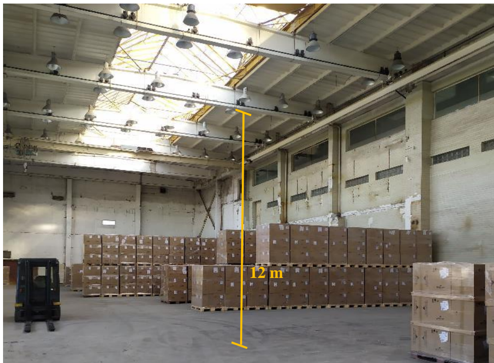
Obrázek 38 - Ukázka výškové kapacity pro výstavbu regálů (vlastní zpracování)
