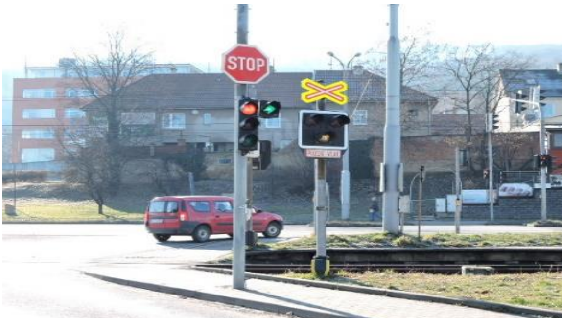
Obrázek 16 Umístění stožáru křižovatky do chodníku (není zajištěna normovaná šířka chodníku – překážka zdroj ohrožení)
