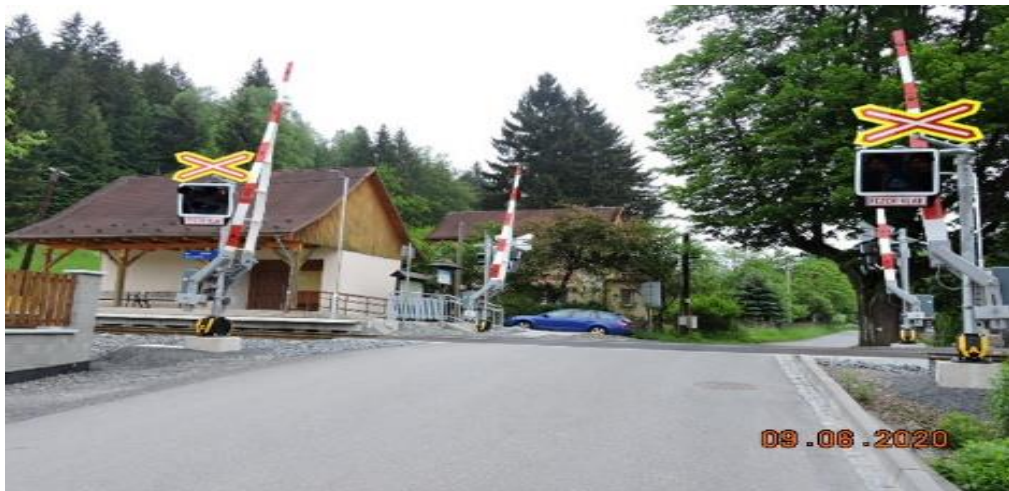
Obrázek 8. Chybějící vodorovné dopravní značení
