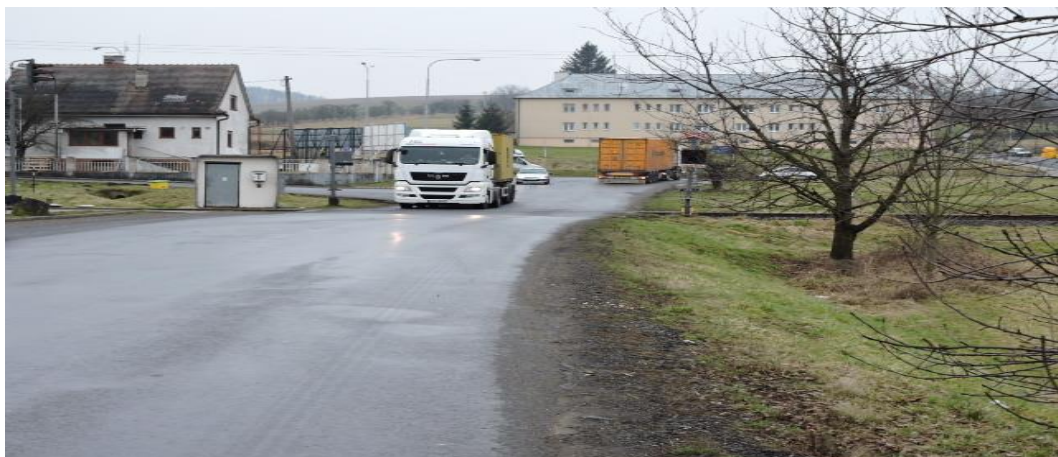
Obrázek 6. Nedostatečné rozhledové poměry
