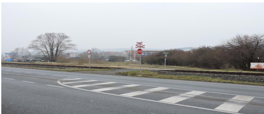
Obrázek 7. Nevhodně umístěné svislé dopravní značení
