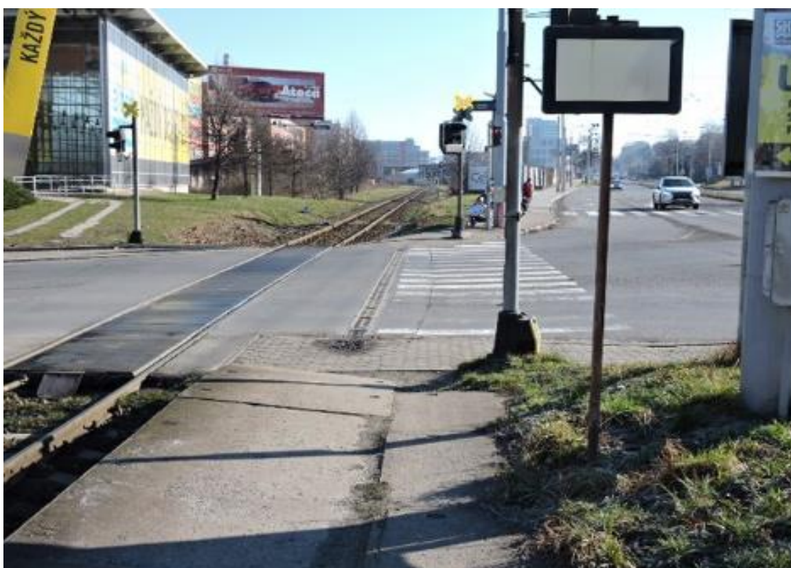
Obrázek 17 Souběh přechodu pro chodce a železniční trati v prostoru za výstražnými kříži v přístupové části zastávky Zlín – Pršté ( PZS a přilehlý přechod v konstrukci
