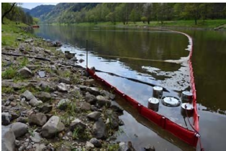
Obrázek 1 Instalace norné stěny na vodním toku (Kolektiv autorů, 2017)
