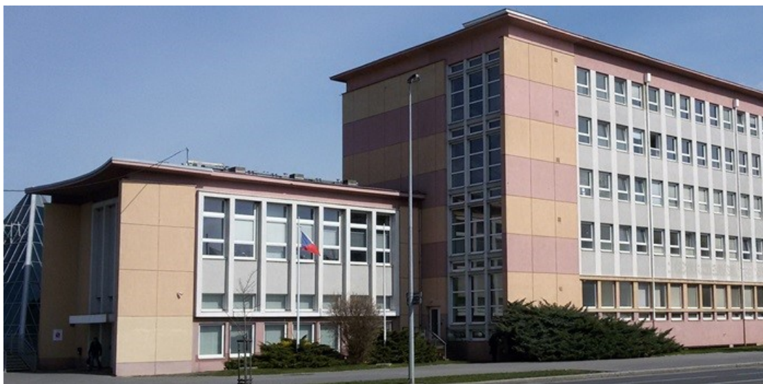
Obrázek 7 – budova ÚZP pro Prahu 4 (MČ Praha 4, © 2013)
