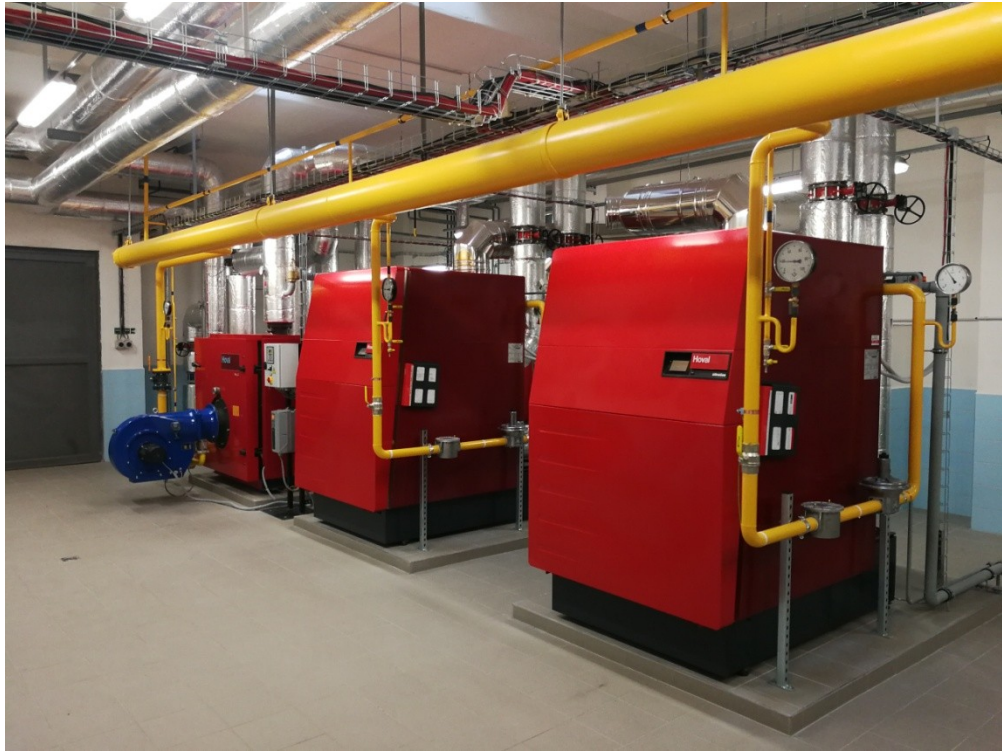
Obr. 11. Stacionární kotle (vlevo s externím hořákem) [vlastní]
