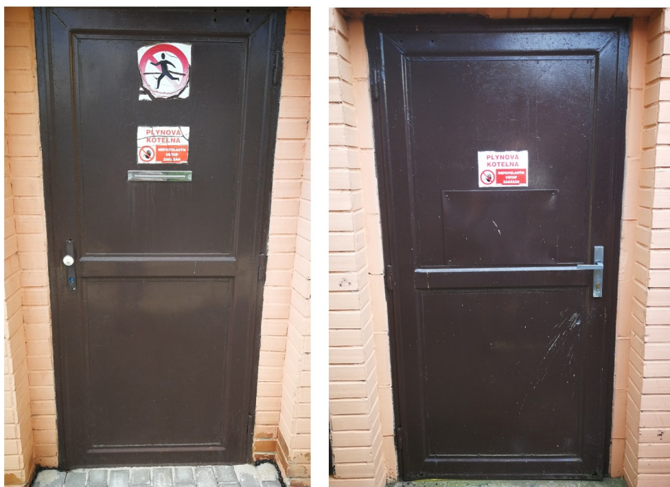
Obr. 38. Dveře do kotelny (vlevo) a do místnosti obsluhy (vpravo) [vlastní]
