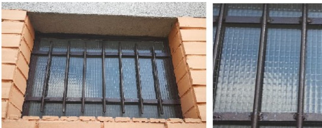
Obr. 39. Okno s vnější mříží (vlevo) a ocelová mřížka vnitřní (vpravo) [vlastní] Dále se na fasádě nachází větrací otvor s vnější a vnitřní mřížkou, také ve výšce 230 cm.
