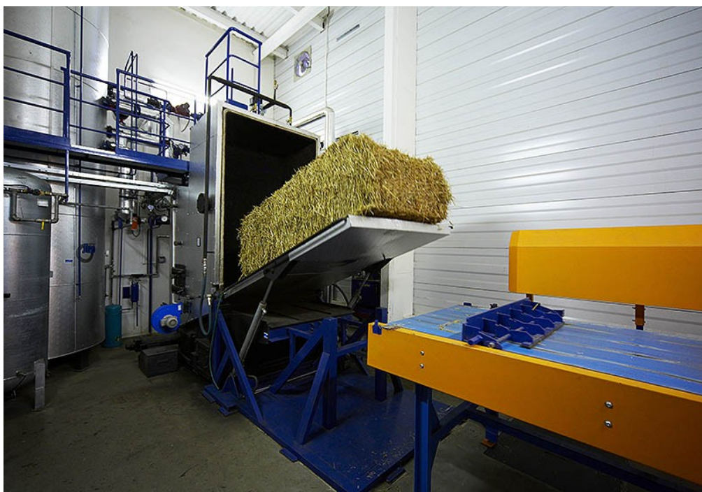
Obr. 5. Kotel na spalování celých balíků slámy [10]
