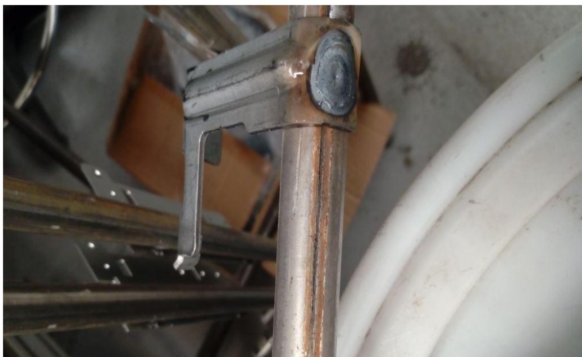
Obrázek 9 Rez na plynovém vedení (interní materiály)
