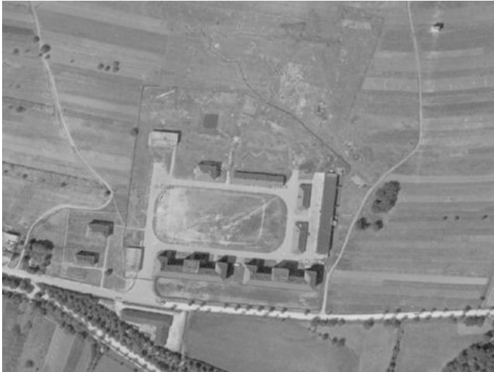
Obrázek 16 Letecký pohled na kasárny, rok 1947 (zdroj: vojensko.cz)
