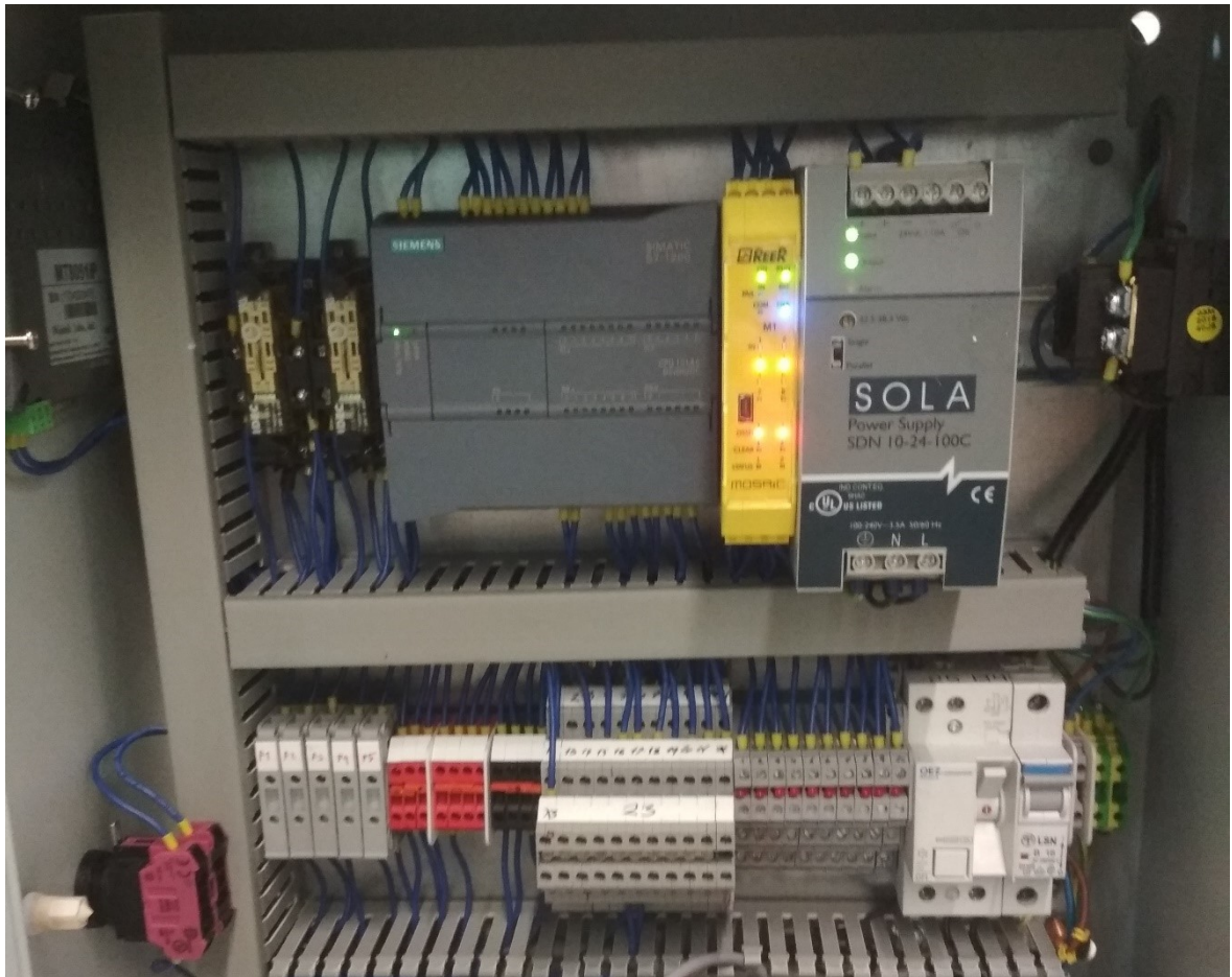
Obrázek 49 Realizace zapojení
