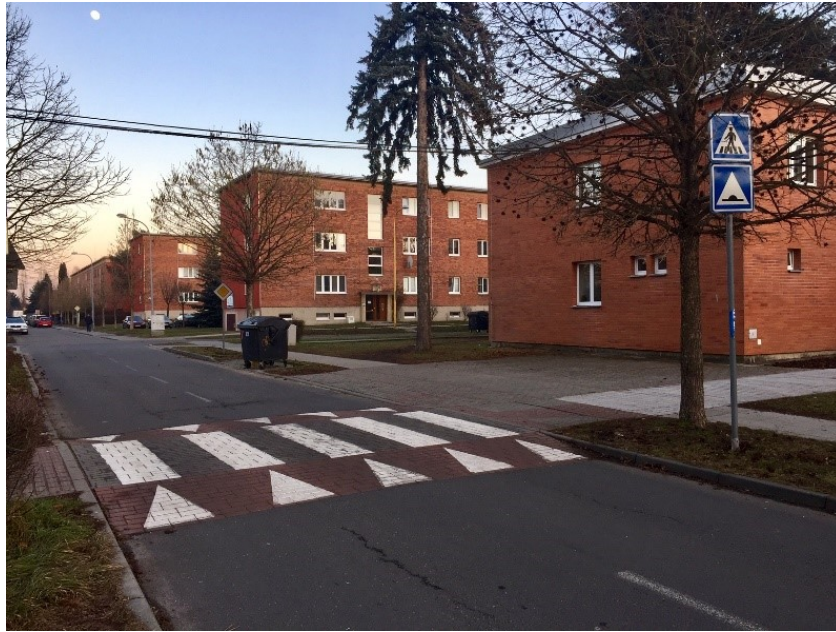
Obr. 4 Dlouhý zpomalovací práh s integrovaným s přechodem pro chodce Otrokovice [zdroj vlastní]
