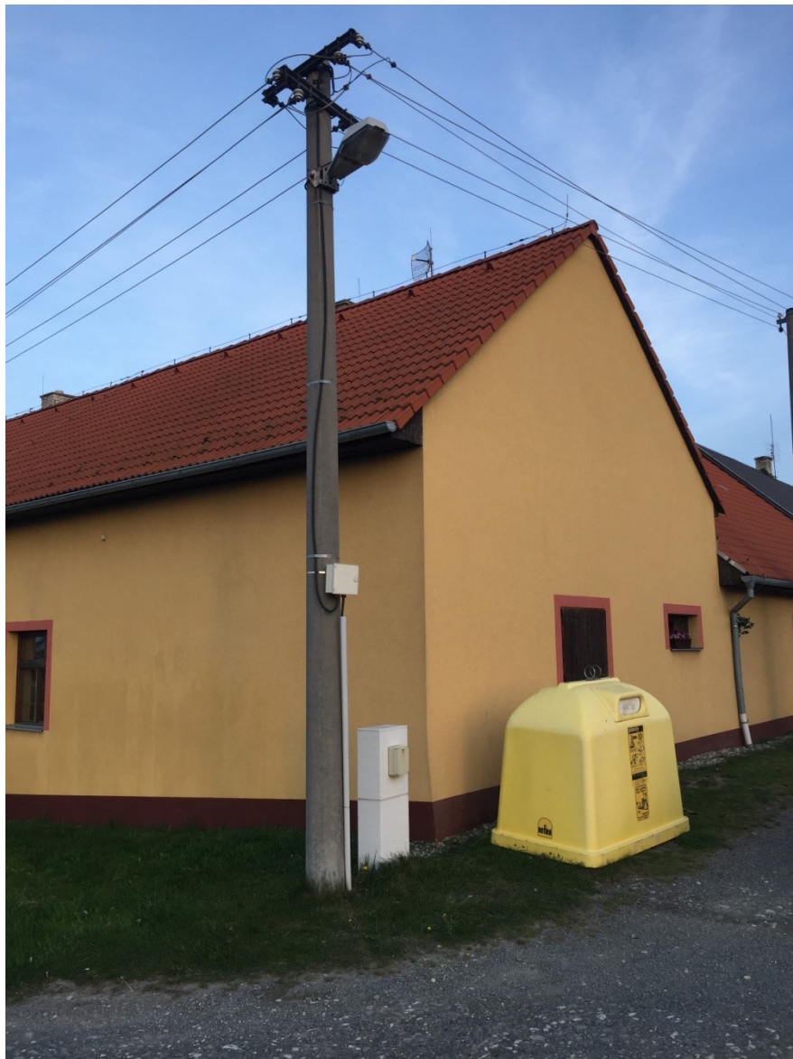
Obr. 2 Sloup elektrického vedení spolu s VO [zdroj vlastní]
