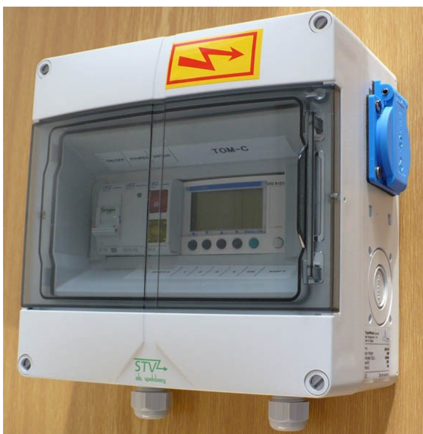
Obrázek 34 Domovní rozvodnice na monitorování činnosti [34]
