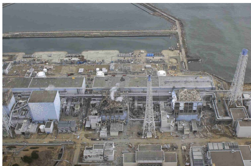
Obrázek 5: Jaderná elektrárna Fukušima [20]
