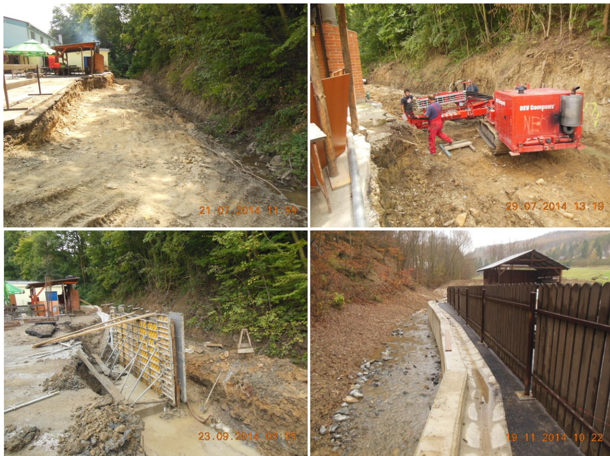
Obr. 3 Sanace sesuvu půdy v obci Břestek [27]
