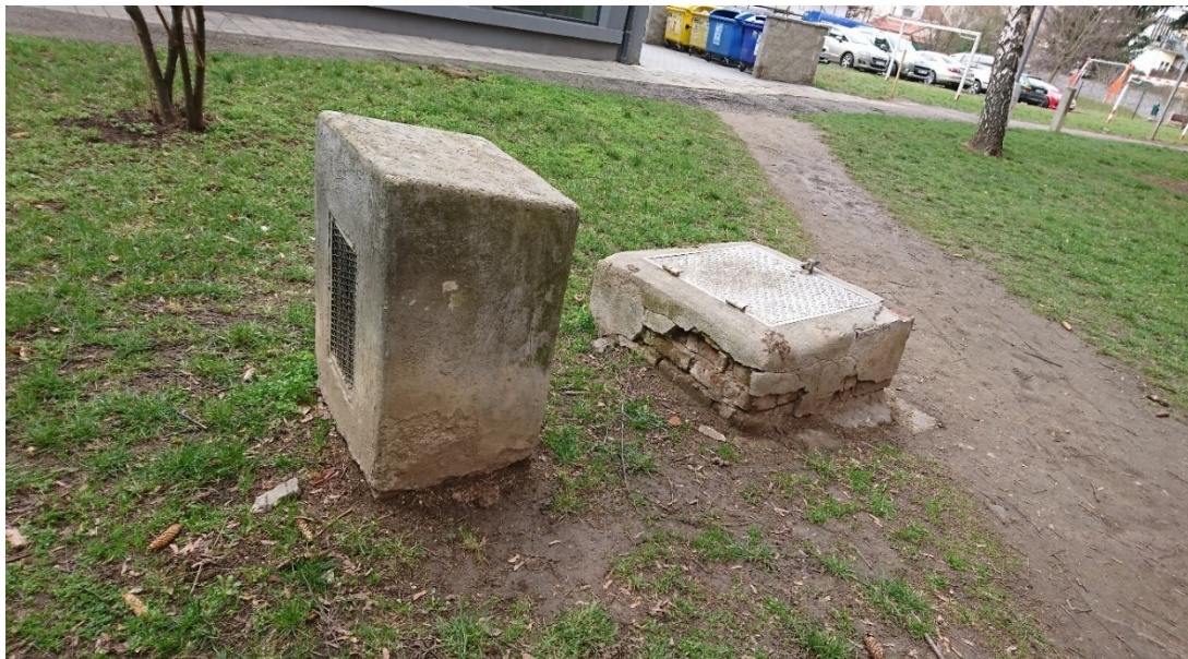
Obrázek 62 – nouzový výlez a nasávací místo. [32]
