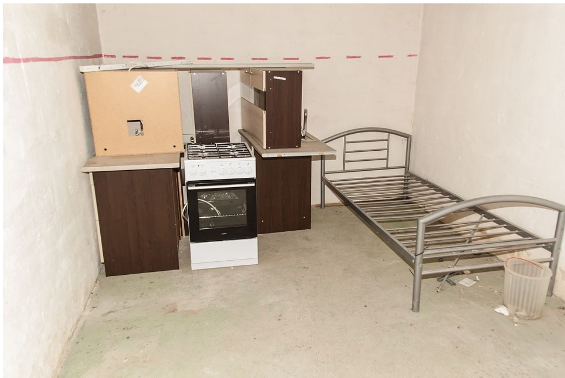
Obrázek 19 – současný stav místnosti pro ukryvané. [32]
