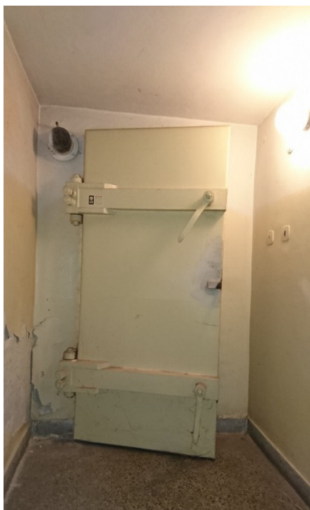
Obrázek 3 – hlavní vstup do krytu. [32]
