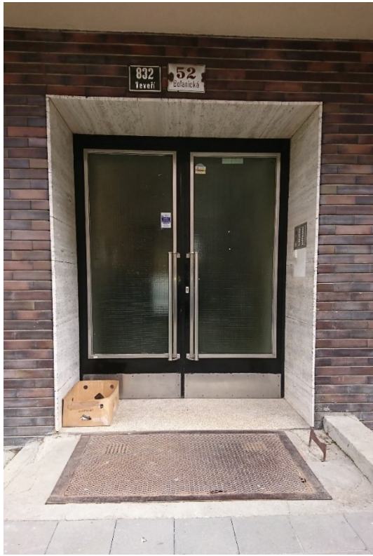
Obrázek 54 – východ nouzového výlezu. [32]
