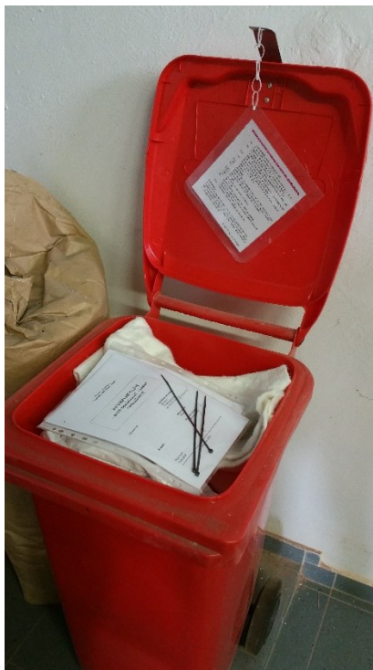
Obrázek 6 – Havarijní souprava určená pro pracoviště „Strojovna chladícího zařízení“, zdroj: [vlastní]
