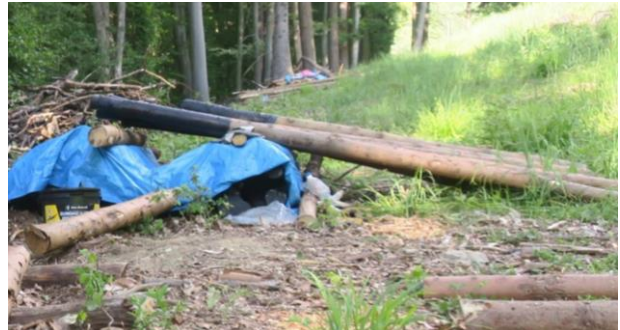
Obr. 3 – Nátěr gumo-asfaltovou hydroizolací
