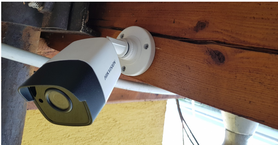
Obrázek 80: Zapojení kamery Hikvision DS-2CE16D8T-IT/28 (zahrádka v1).
