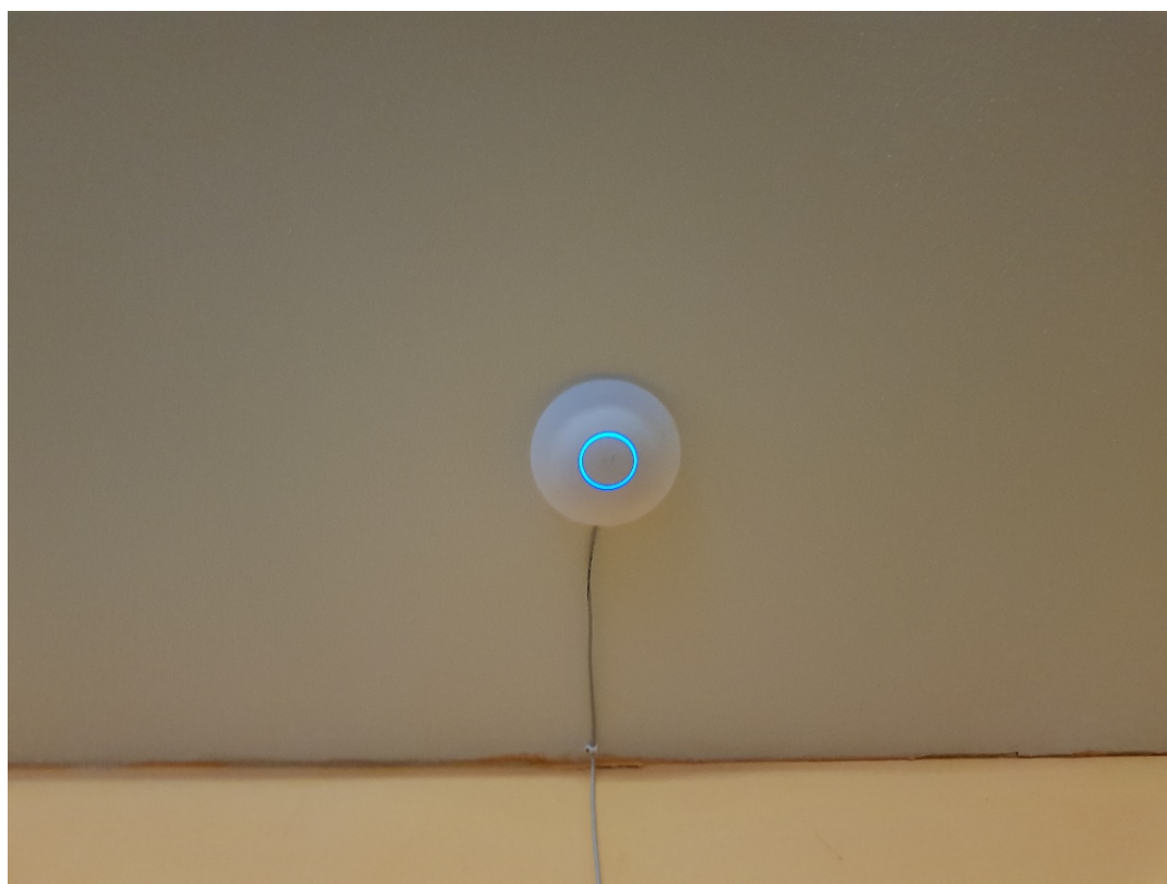
Obrázek 67: Zapojení Access Pointu Ubiquiti UniFi AP AC LR (detail).
