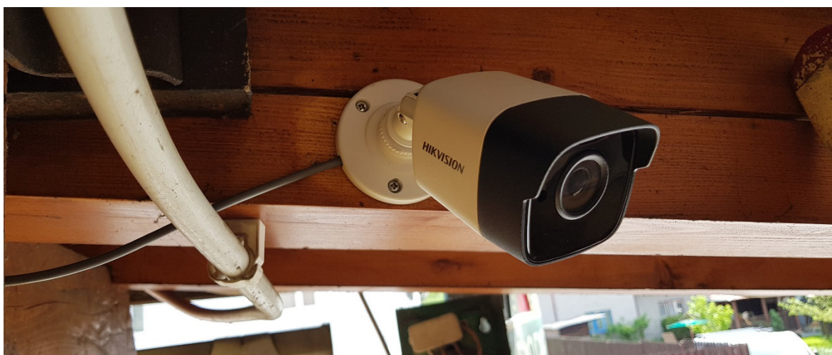
Obrázek 81: Zapojení kamery Hikvision DS-2CE16D8T-IT/28 (zahrádka v2).
