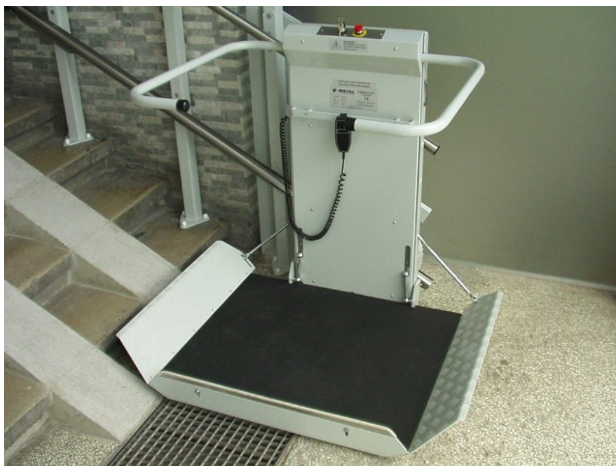
Obr. 2. Šikmá schodišťová plošina Delta [Zdroj: vlastní]
