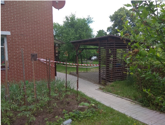
Obrázek 12 – Zajištěný hlavní vchod
