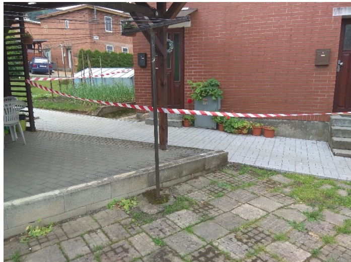
Obrázek 13 – Zajištění místa vniknutí pachatele
