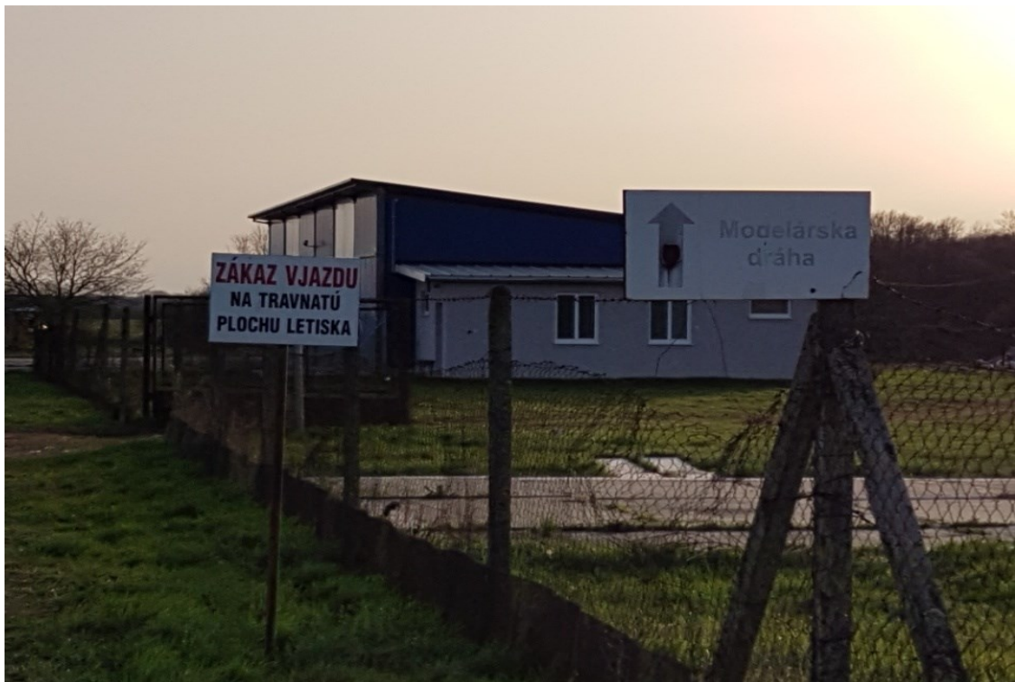
Obr. 28. Poškodený drôt na ľavej strane od vchodu do vnútornej časti letiska [vlastný]
