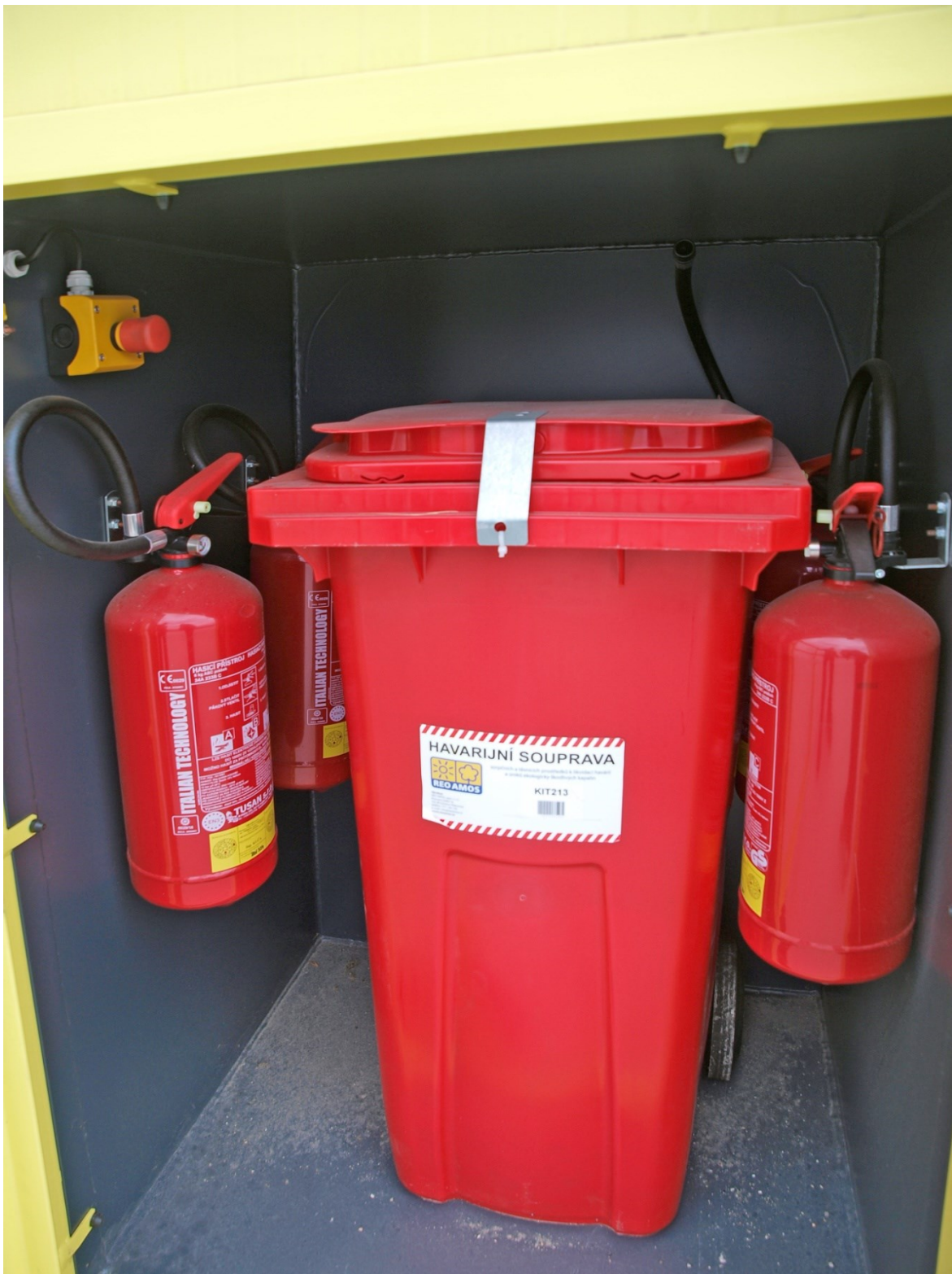
Obr. 17 Havarijní souprava s hasicími přístroji čerpačí stanice [Zdroj: vlastní]
