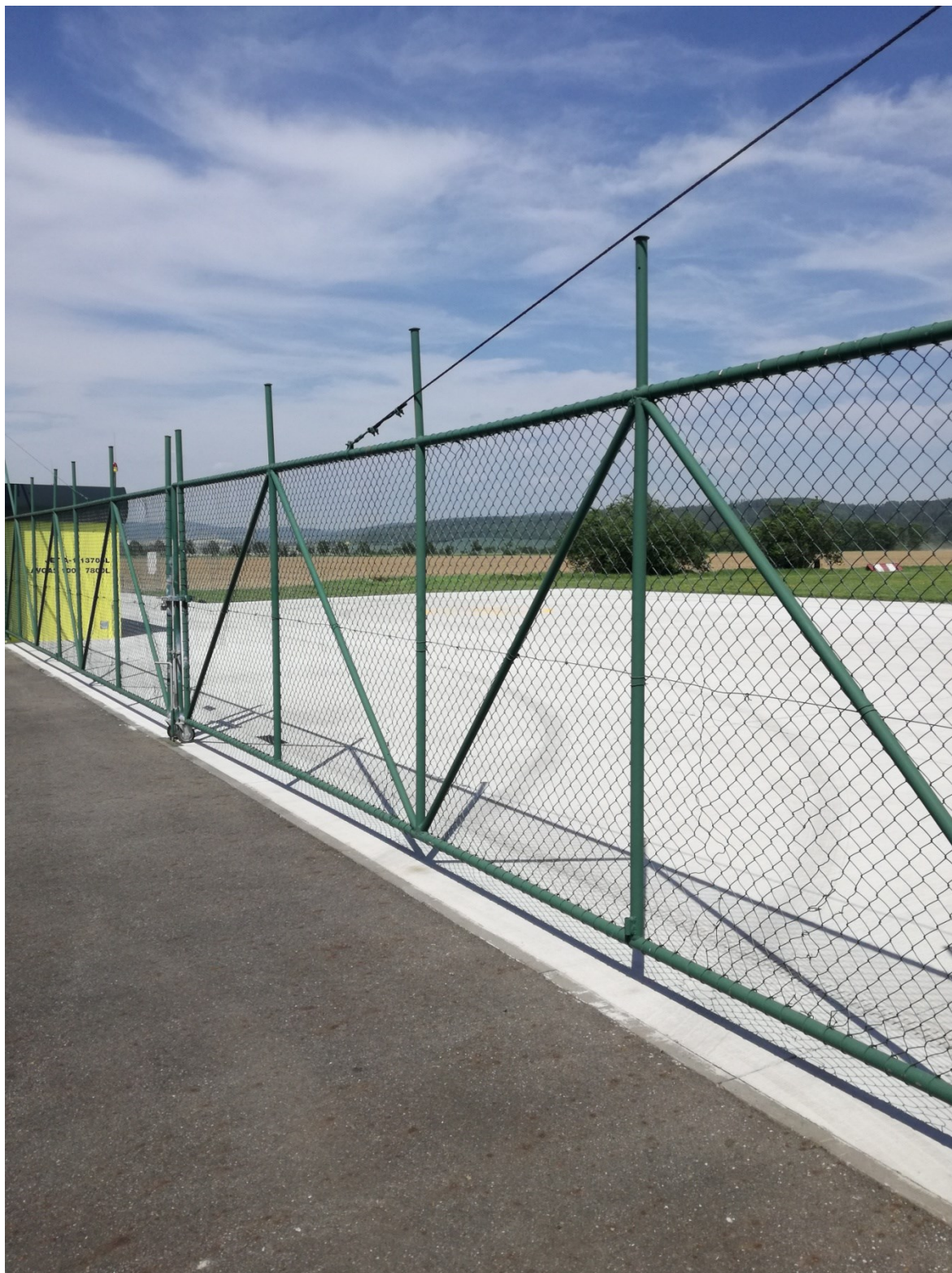
Obr. 4 Dvoukřídlová brána na RWY [Zdroj: vlastní]
