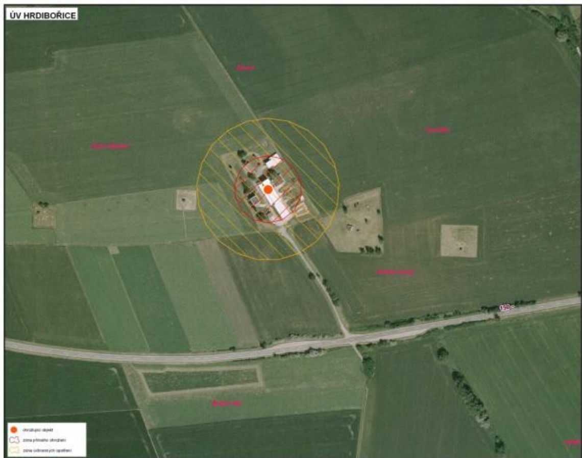
Obr. 4. Úpravna vody v Hrdibořicích
