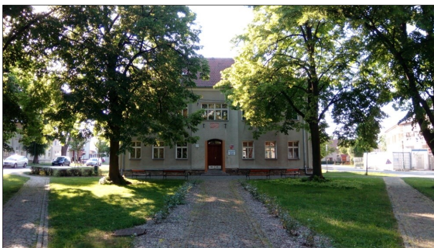
Příloha 5: Druhá budova ZŠ (zdroj: vlastní)
