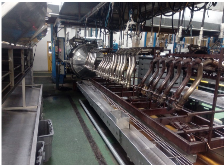
Obrázek 17. Avtokláv (vlastní zpracování)
