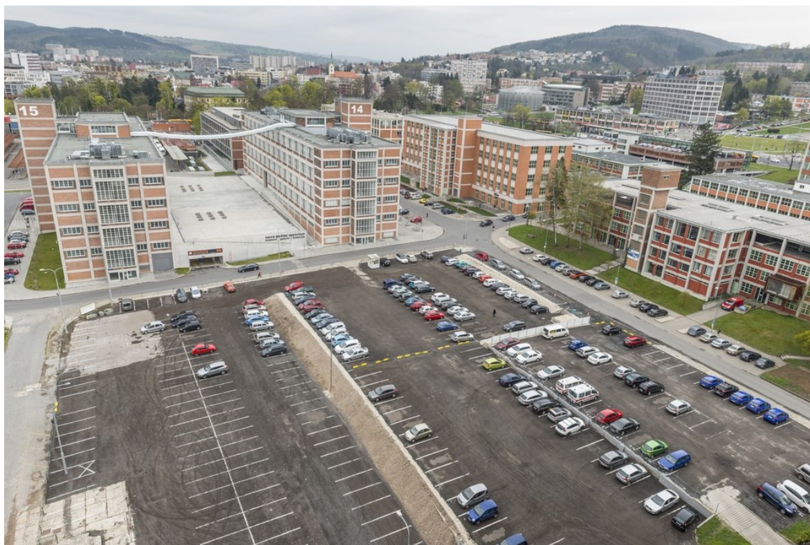
Obrázek č. 24: Plocha vzniklá po zbourání dvou budov v areálu Svit
