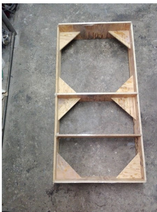
Obr. 48. Vyrobené žebrové bednění
