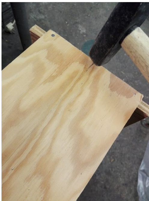
Obr. 47. Výroba žebrového bednění
