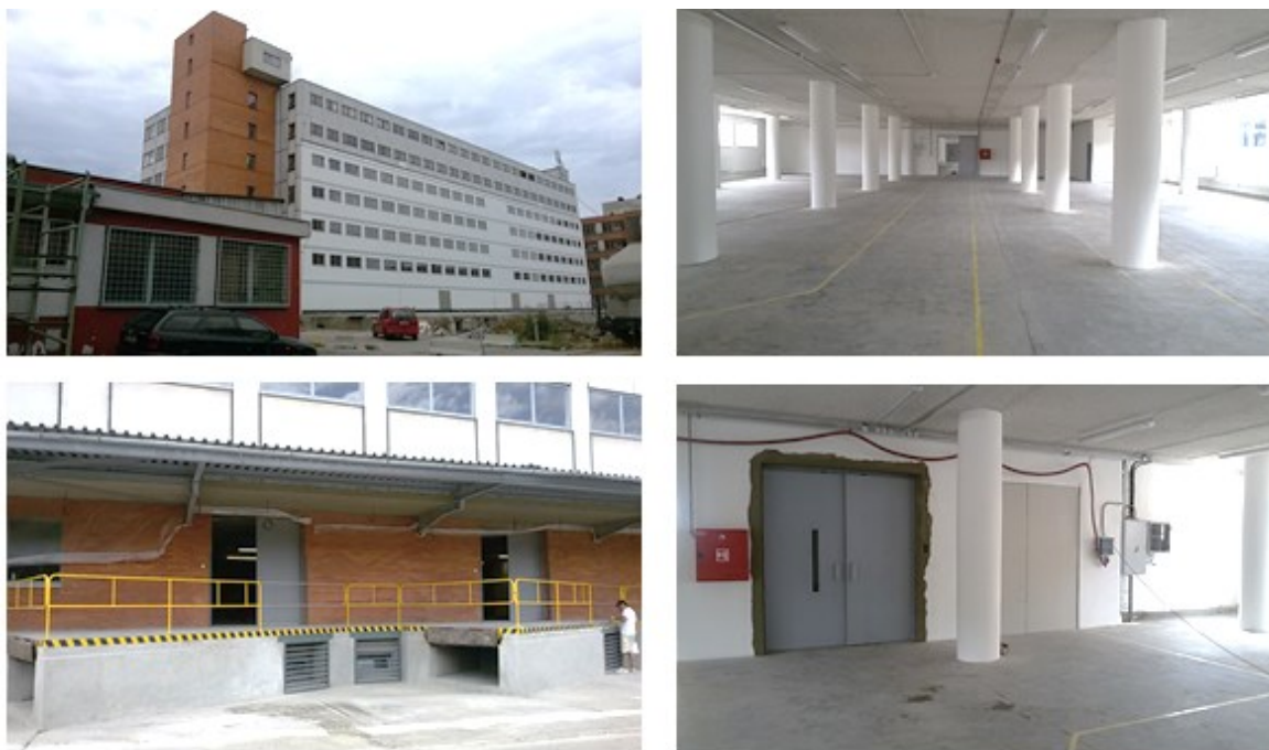
Obr. 17. Nové prostory skladu (vlastní zpracování)
