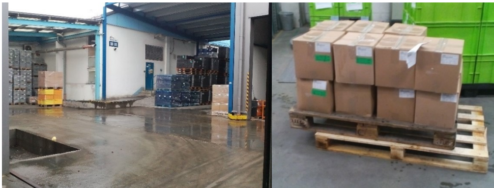
Obr. 55 Nezasťřešený prostor mezi výrobní halou a expedičním skladem (vlastní zpracování) a Obr. 56 Deštěm poničené balení před skladem expedice (vlastní zpracování)
