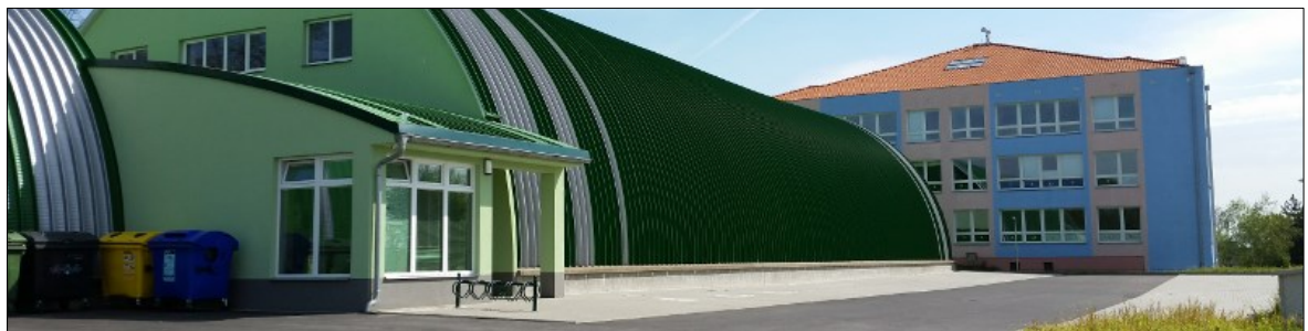
Figure 3: Business location (Sportovní Hala Hrušovany n. Jev., 2017)
