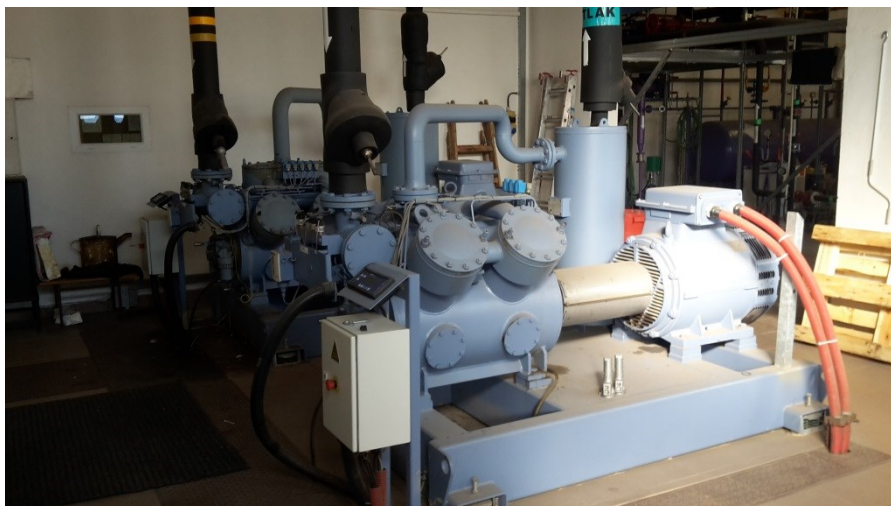
Obrázek 2 Kompresory chlazení
