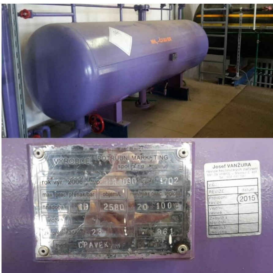
Obrázek 3 Vysokotlaký sběrač (Zásobník)
