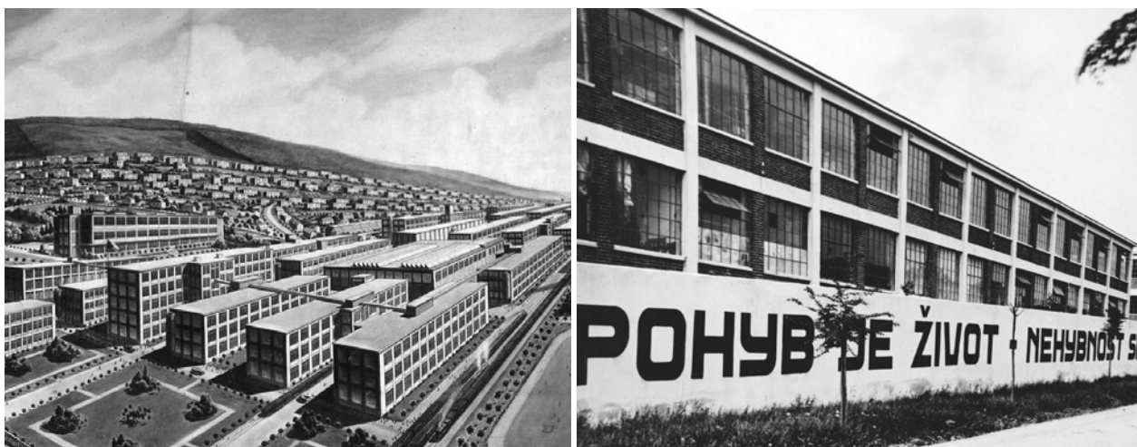
Obr. 52: Areál Svit / Archivní fotografie původní zdi
