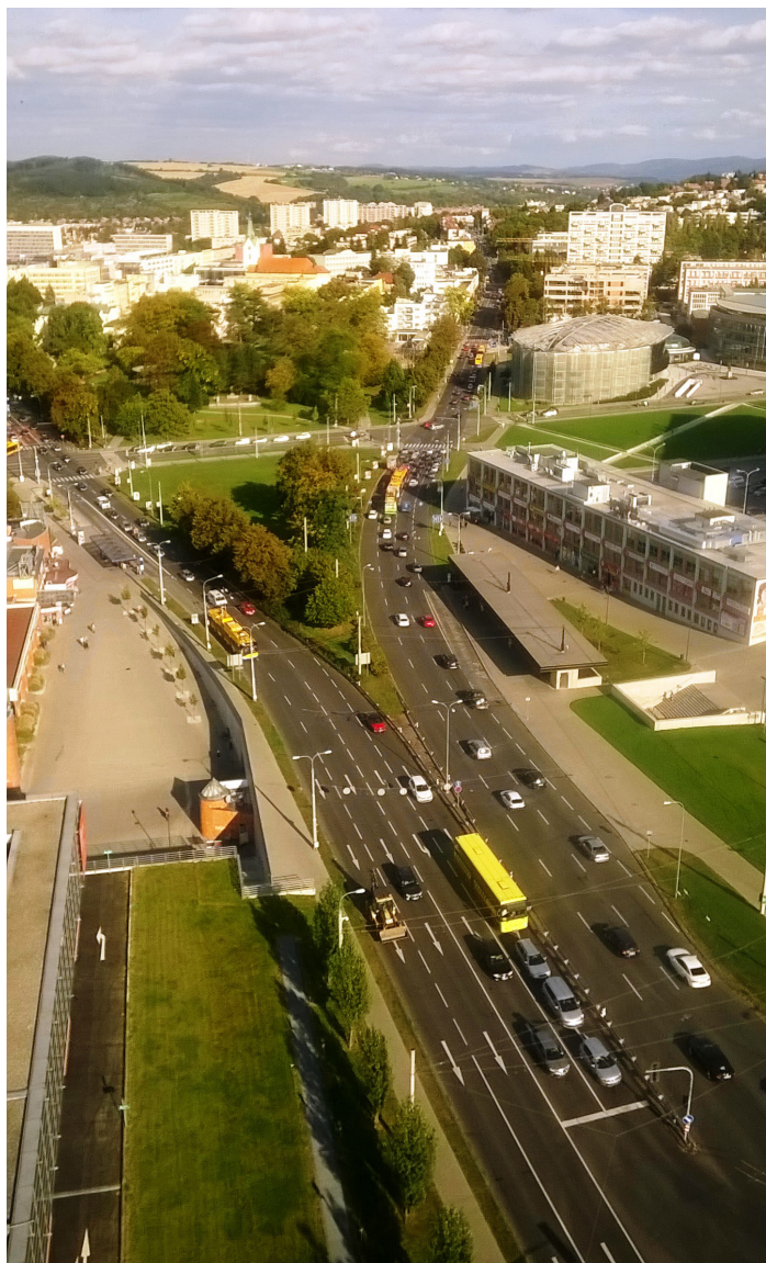
Obr. 53: Náměstí Práce z ptačího pohledu
