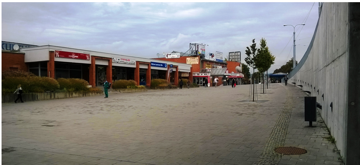
Obr. 55: Vchod do podchodu z areálu bývalé továrny, pohled k trolejbusové zastávce
