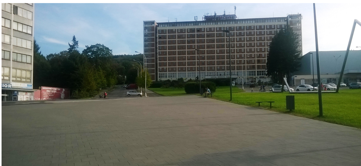
Obr. 63: Pohled od podchodu
