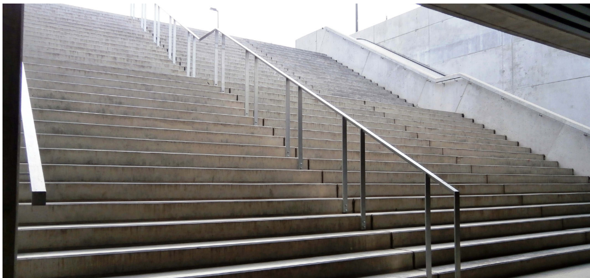
Obr. 58: Hlavní schodiště s eskalátorem
