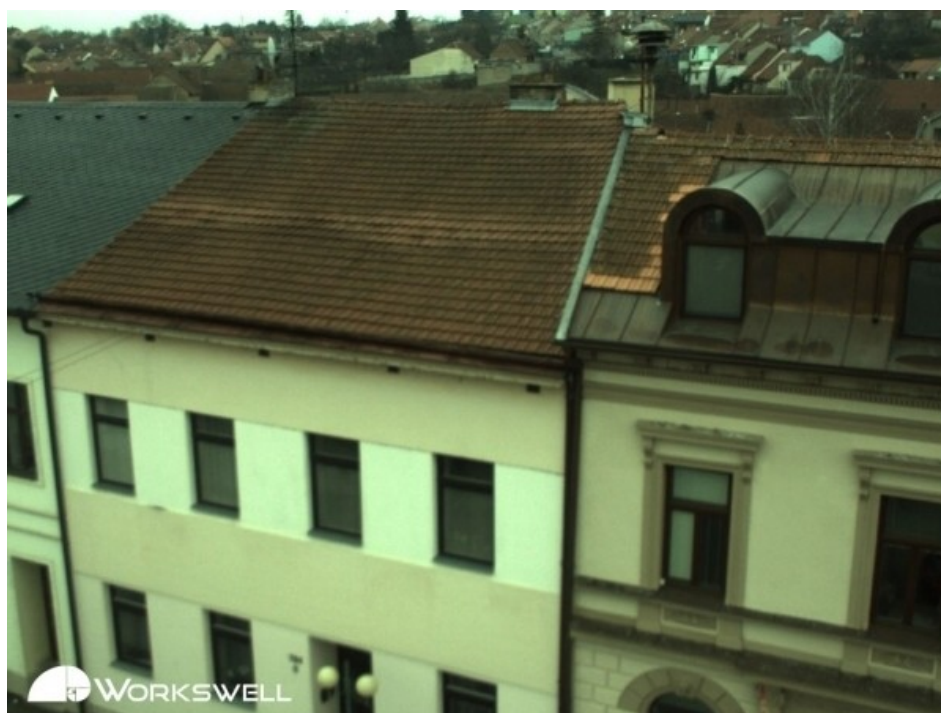
Obr. 38 Ilustrační snímek budovy z dronu, kamera WIRIS [26]
