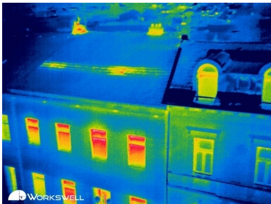
Obr. 37 Ilustrační termosnímek budovy z dronu, kamera WIRIS [26]
