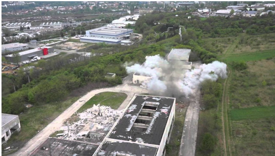
Obr. 34 Foto ze cvičení požáru a zřícení budovy [25]
