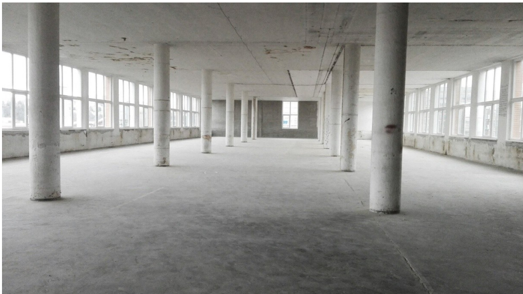
Obr. 30 Výstavní prostor v budově 64, areál Svit, Zlín
