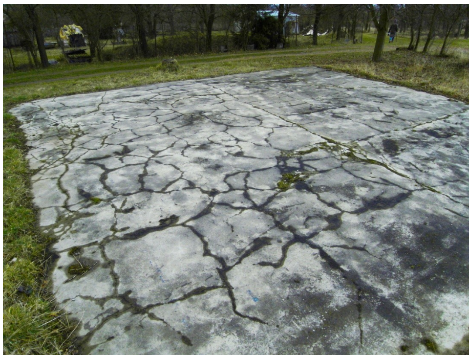
Obr. 4 Betonové hřiště u zahrady, 2017
