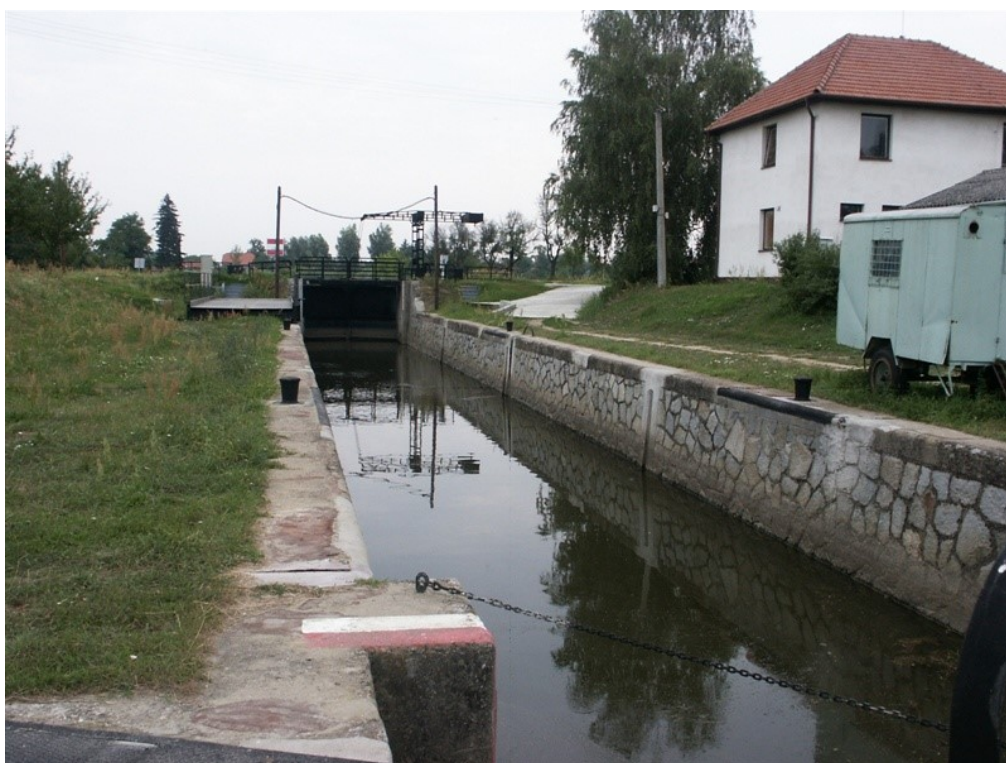
Obr. 2 Plavební komora na Baťově kanálu (Baťův kanál)
