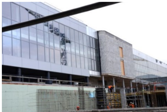
Obrázek 5: Výstavba univerzitního kampusu CESEB za 444 mil. Kč [26]
