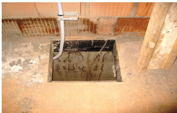
Obrázek 22: Nezajištěný otvor [26]
