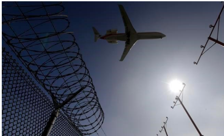
Obr. 1. Oplocení areálu včetně vrcholové zábrany[26]
