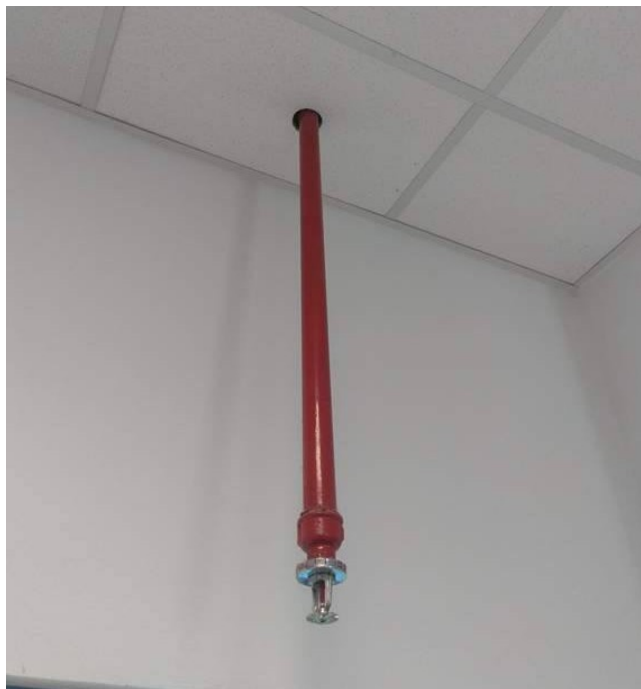
Obr. 8 Sprinklerová hlavice [vlastní zpracování]
