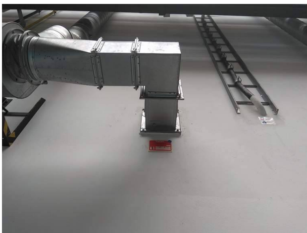
Obr. 15 Požární klapka [vlastní zpracování]
