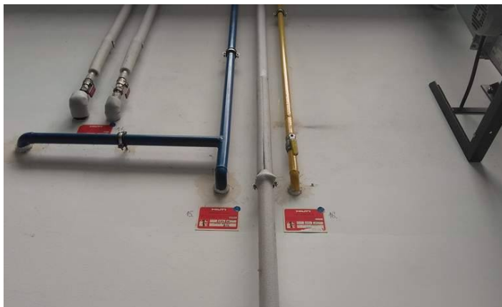
Obr. 14 Požární ucpávky [vlastní zpracování]
