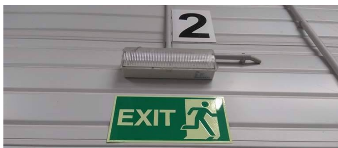
Obr. 16 Nouzové osvětlení [vlastní zpracování]
